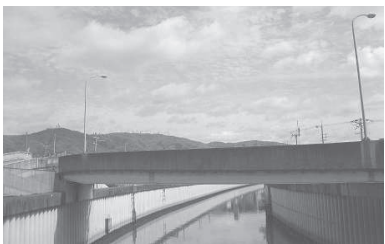
北西方向から見た御供田新橋
